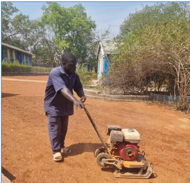
Der Laterit in der Einfahrt wird verdichtet.
