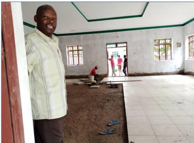
Israel Kawuka überwacht die Fliesenarbeiten im Saal der Bibliothek.
