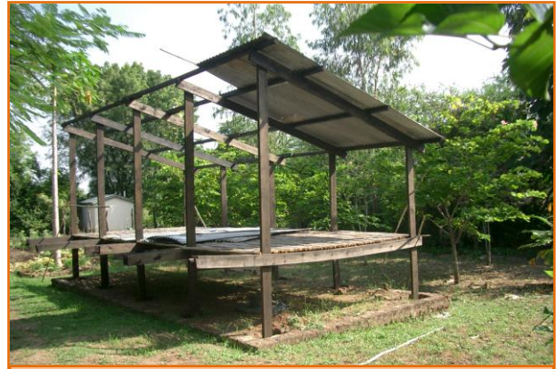
Der Bau des Hühnerstalls hat begonnen
