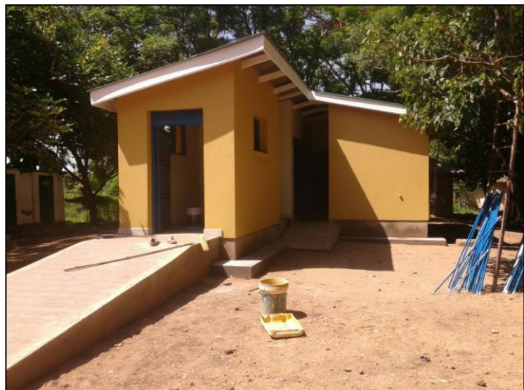
Das neue Sanitärgebäude ist fertig.
