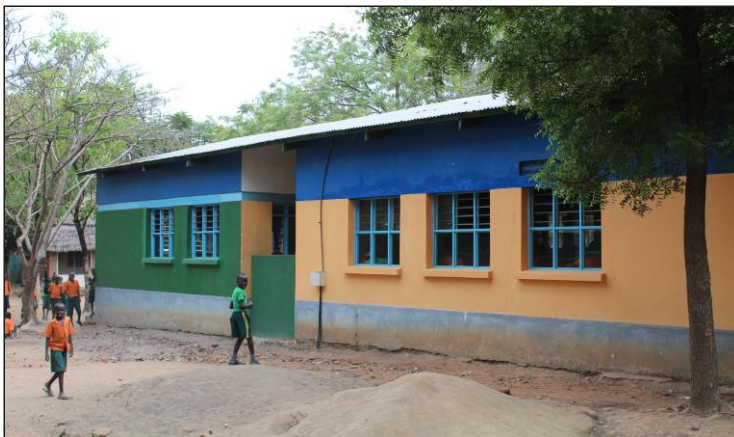
Neue Fenster in einem vor zehn Jahren renoviertem Klassenzimmer
